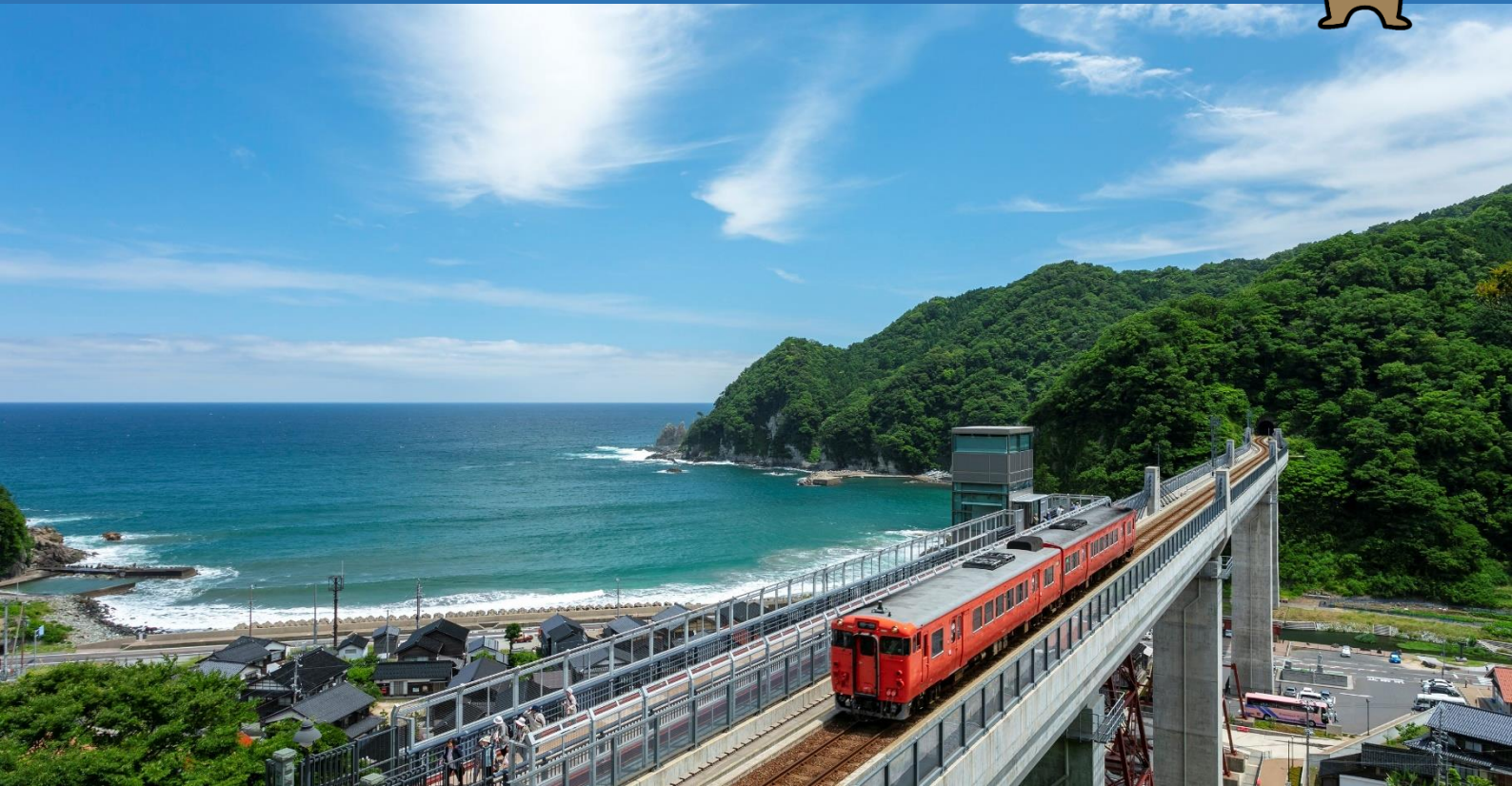
余部鉄橋「空の駅」
